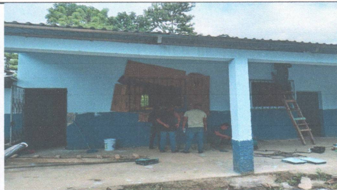
Foto 4: Se esta pintando balcones y puertas del establecimiento.
