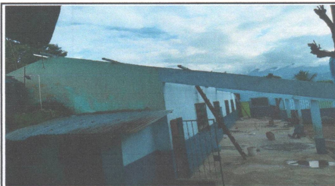
Foto 3: Colocando laminas para el techo del establecimiento
