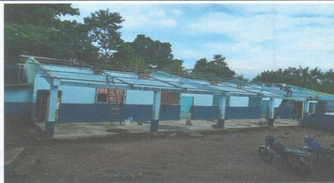
Foto 2: Se cambio la estructura del techo.
